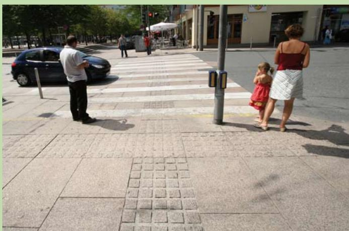
Zugang zu einer Straßenüberquerung mit Akustikgerät.
